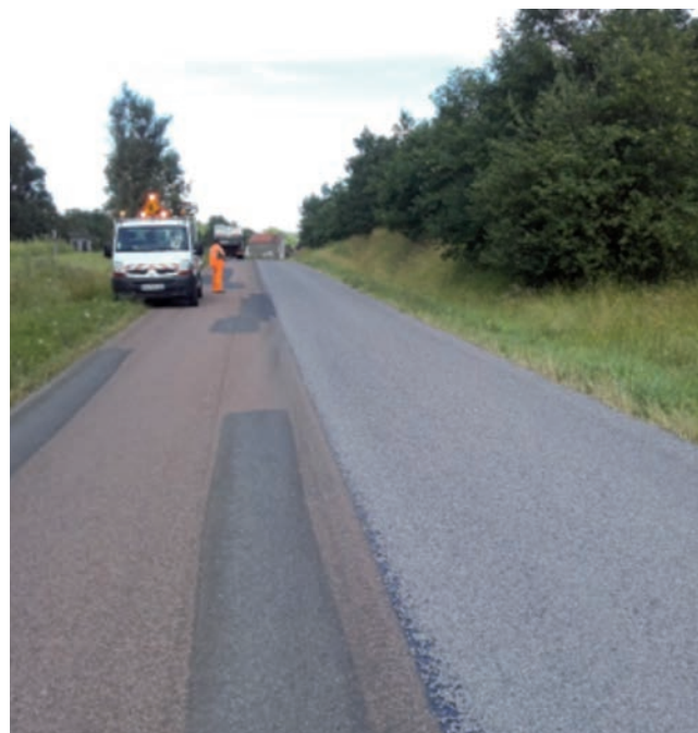
Photo 3 Application en ESU sur Route Départementale
