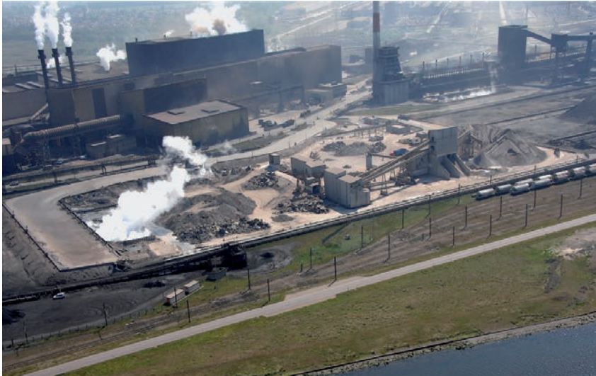
Photo 1 implantation de la société SGA à côté de l'aciérie ArcelorMittal de Dunkerque
