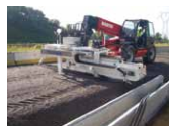
Olivia en action pour la pré-fissuration de la grave ciment
