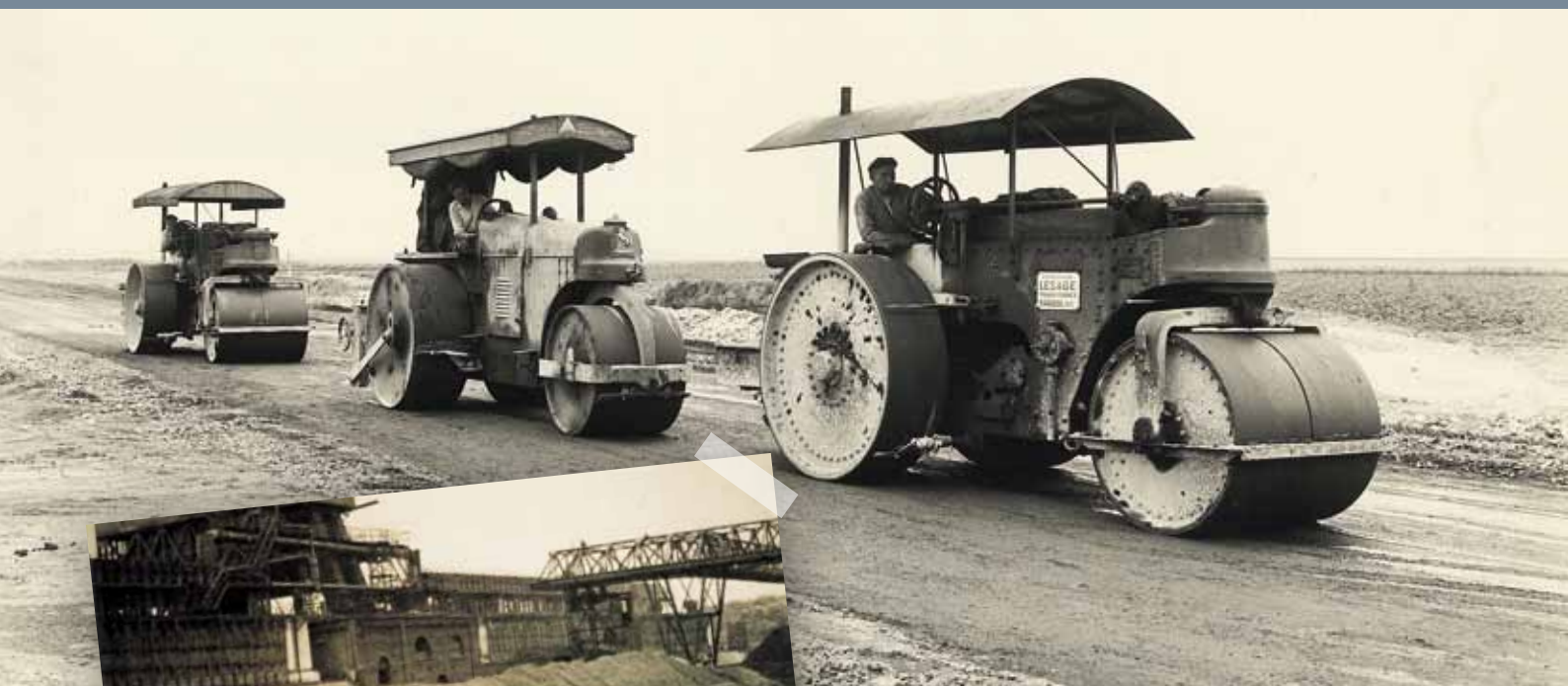
Cylindrage de la couche de laitier (1954) © photothèque Eurovia
