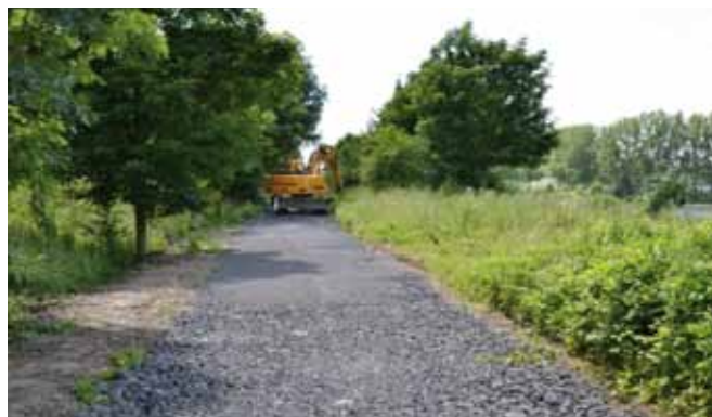
Mise en place de la couche de forme
