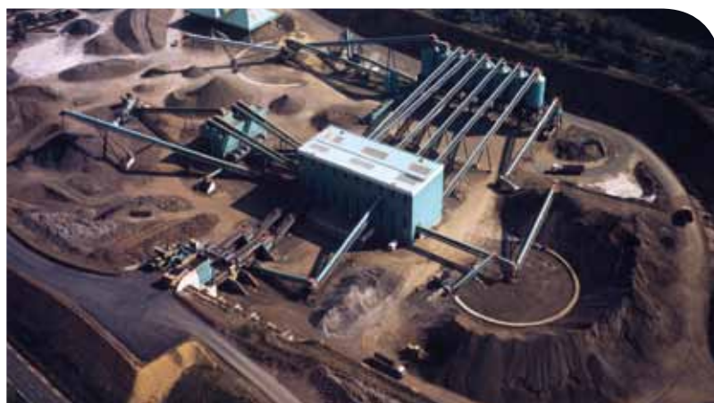
Photo 1 Installation SLAG à Moyeuvre-Grande
