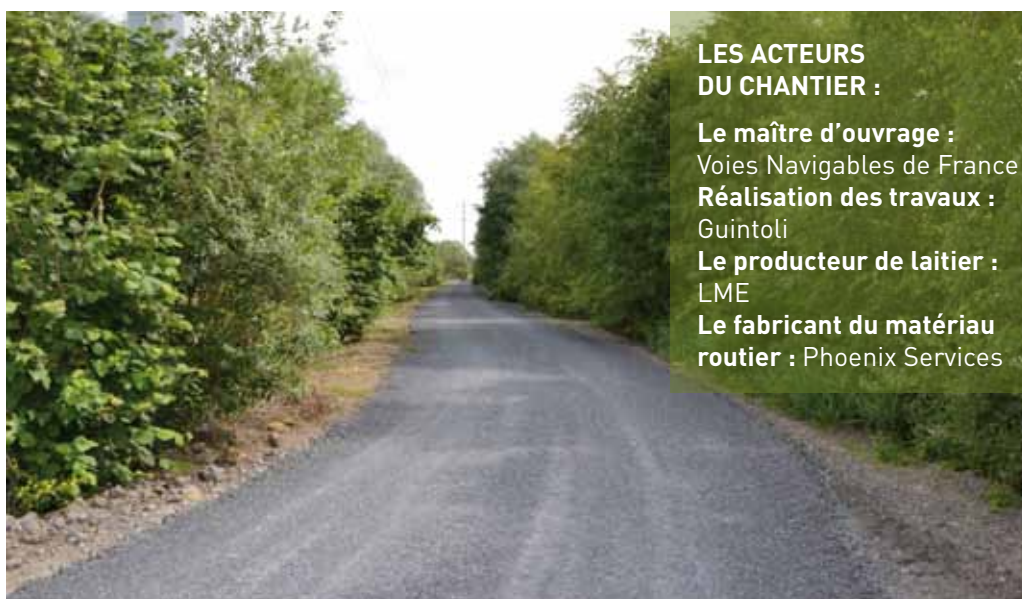
Chemin revêtu d'un enduit gravillonné
