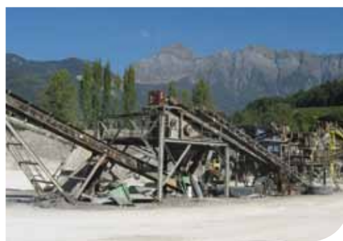
Photo 3 Plate-forme d'élaboration des matériaux alternatifs (site Ugitech)
