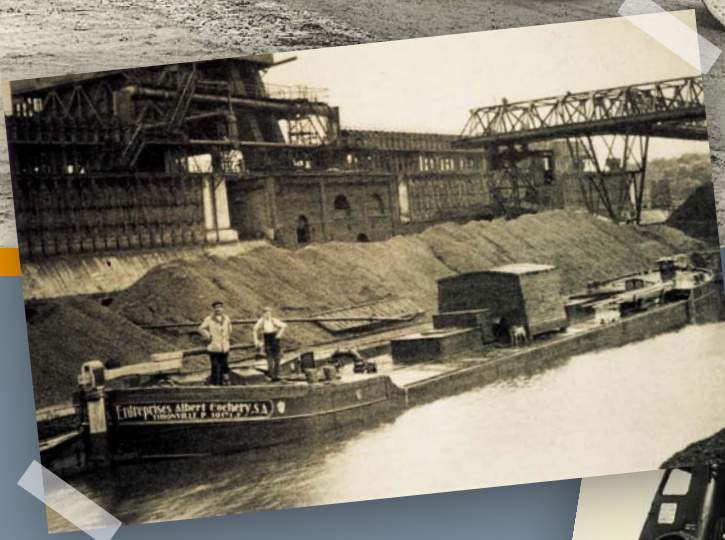
Péniches des EAC assurant le transport des matériaux enrobés (1935) – société Rol Lister © photothèque Eurovia
